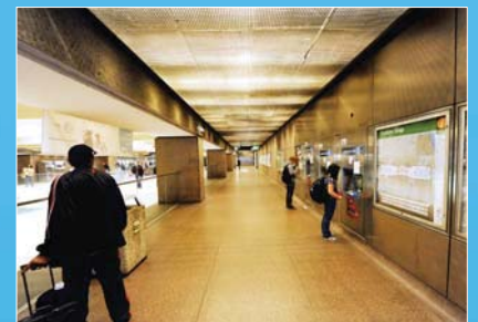
Reemplazo de la iluminación y las lámparas
