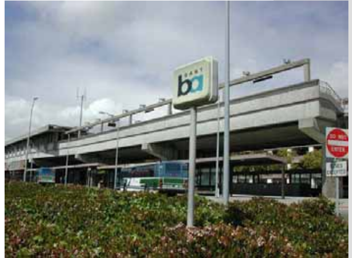
El Cerrito del Norte Station Exterior
